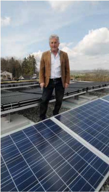
Bauherr Hanspeter Curiger rüstete zwei der drei Gebäude ganzflächig mit PV-Panels aus.
