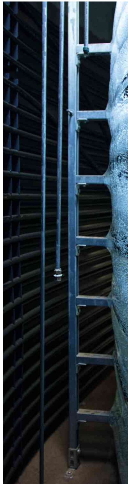
An den Speicherwänden bildet sich kein Eis, womit kein zusätzlicher Druck auf die Wände ausgeübt wird. (Bild: Viessmann (Schweiz) AG)
