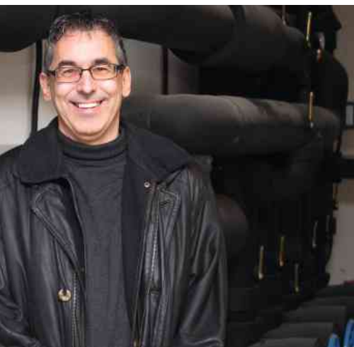
Markus Baumann: «Mit dem grössten Eisspeicher der Schweiz versorgt die Viessmann (Schweiz) AG die fünf Mehrfamilienhäuser des Neustudenparks in Amriswil effizient mit Wärme und Kühlung.»
